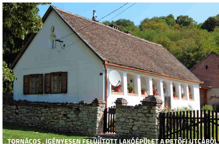
TORNÁCOS, IGÉNYESEN FELÚJÍTOTT LAKÓÉPÜLET A PETŐFI UTCÁBÓL
