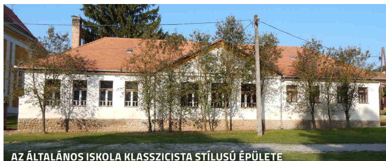
AZ ÁLTALÁNOS ISKOLA KLASSZICISTA STÍLUSÚ ÉPÜLETE
