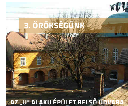
AZ „U” ALAKÚ ÉPÜLET BELSŐ UDVARA
